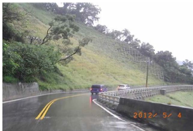
圖 31 臺 24 線莫拉克災修工程設計採用綠色工法
