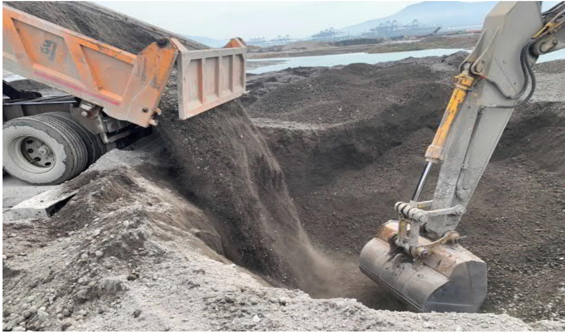
圖 3-18、「物流倉儲區 (第二期至第四期)」使用轉爐石填海造地
