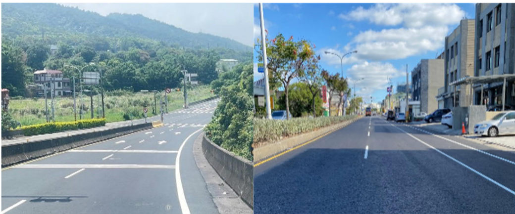
圖 3-20、省道路面改善工程（使用再生瀝青混凝土）完工照
