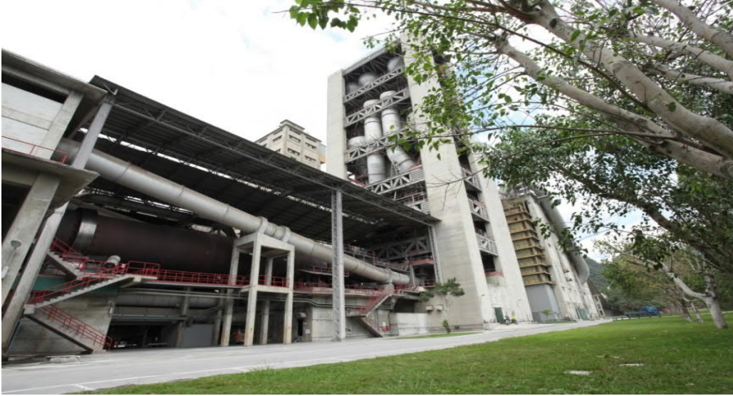
圖 3-9、亞洲水泥公司旋窯設備
